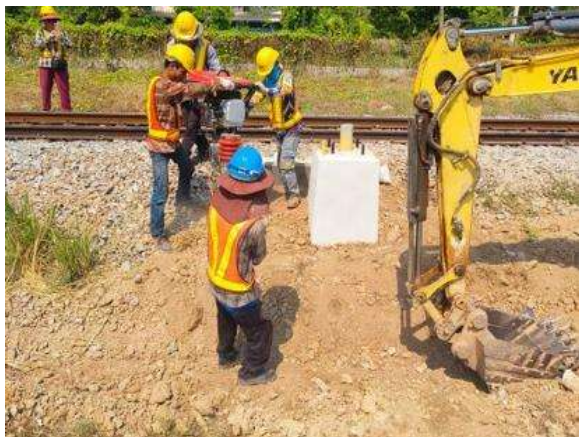
งานก่อสร้างฐานเสา Signal
