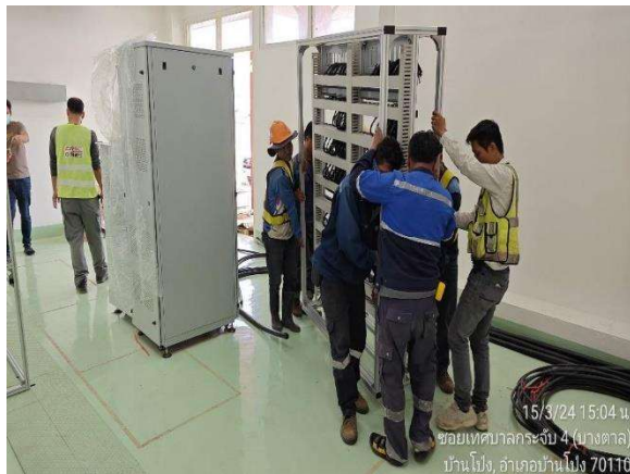
งานติดตั้งอุปกรณ์ในห้อง Relay
