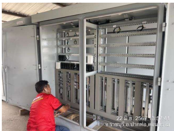
ดำเนินการ Wiring Cable อุปกรณ์ในตู้ LOC
