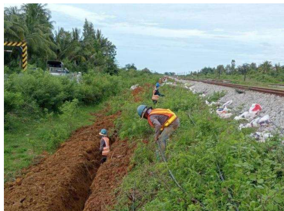
งานก่อสร้าง Cabel Trench and Laying Cabel
