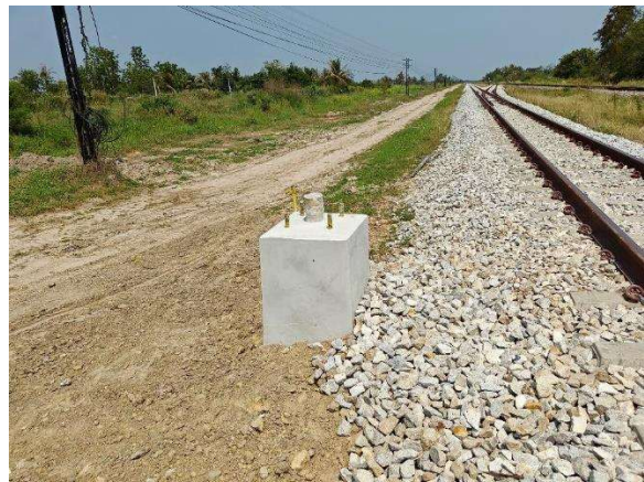
งานก่อสร้างฐานเสา Signal
