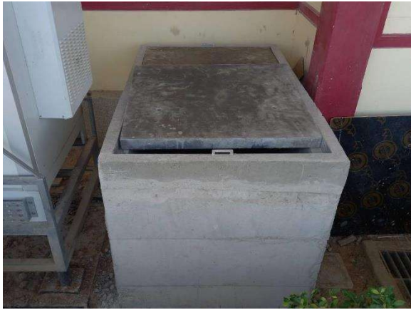
งานก่อสร้าง Main Cable Pit
