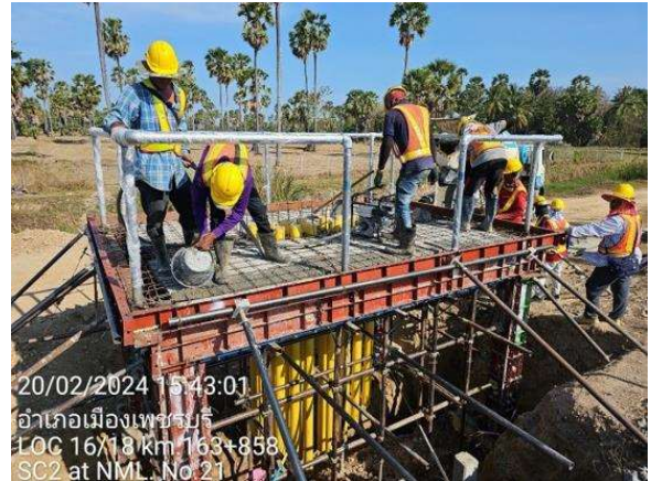
งานก่อสร้าง Main Cable Pit
