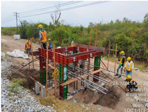
งานก่อสร้าง Main Cable Pit
