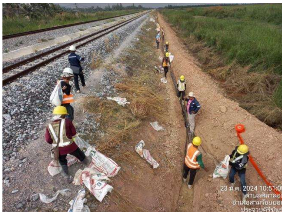
งานก่อสร้าง Cabel Trench and Laying Cabel
