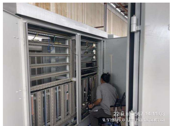
ดำเนินการ Wiring Cable อุปกรณ์ในตู้ LOC
